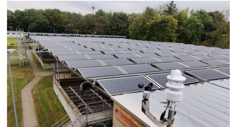
Das erste Solarfaltdach in DE – 243 kWp
