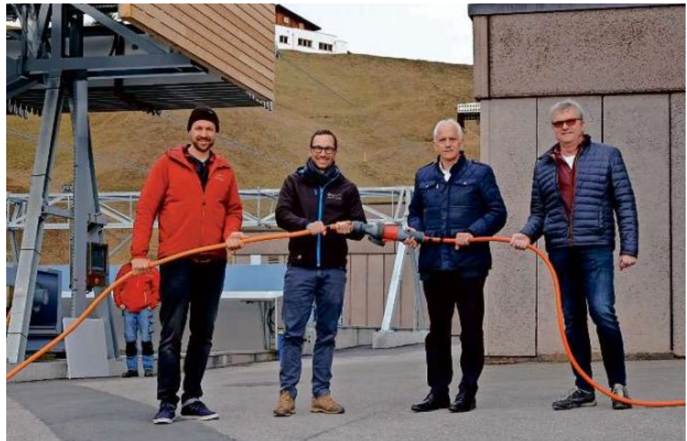
V.l.: Philipp Crivelli (Projektleiter), Gian Andri Diem (geschäftsführender Partner), Tarzsius Caviezel (Landammann) und Stefan Walser (Departementsvorsteher Tiefbau) freuen sich über die Inbetriebnahme der Anlage. Bild: ad
