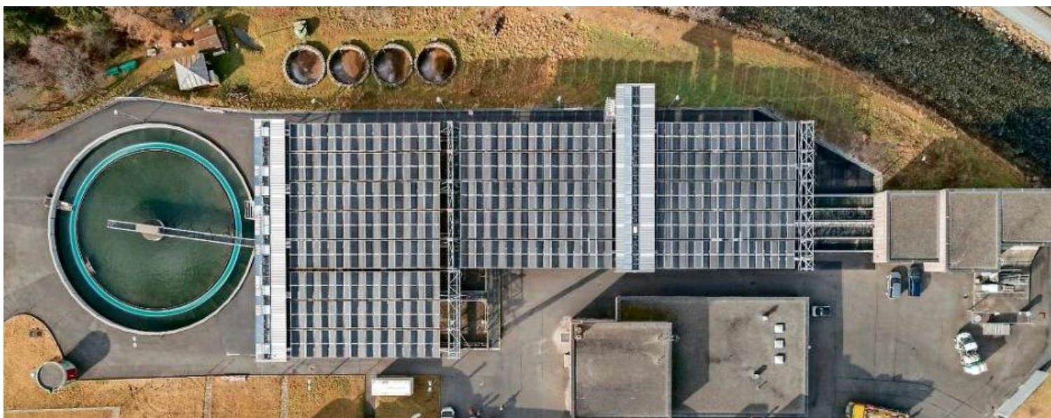
Das «ausgeklappte» Solarfaltdach wurde über dem Klär- sowie dem Sand/Fettfangbecken installiert.
