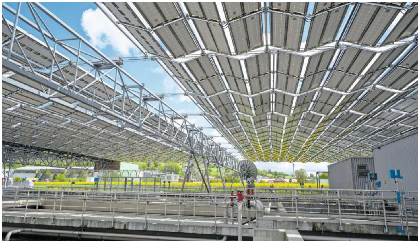
Jeden Tag falten sich 1440 Solarpanels automatisch auseinander – und einzig nachts oder bei Regen zusammen.
