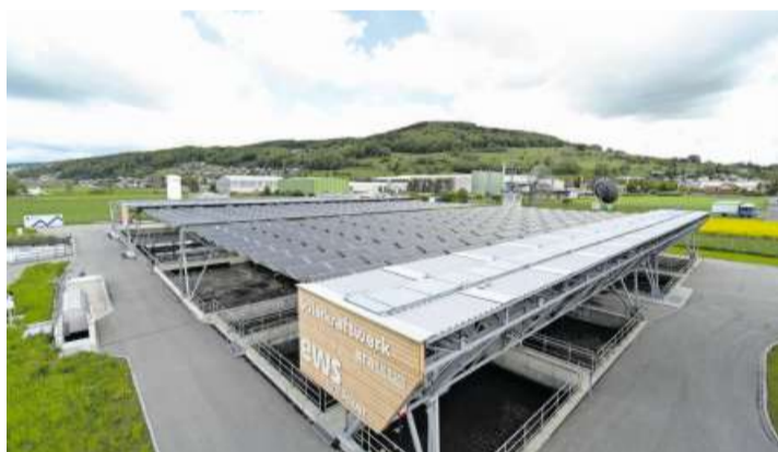
Die Kläranlage in Reinach gehört jetzt auch energietechnisch zu den modernsten ihrer Art.
