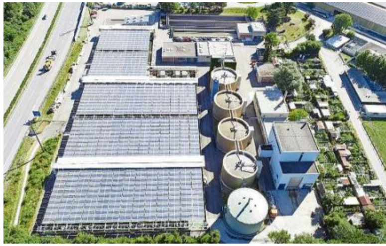
Vielseitig nutzbar: Ein Solarfaltdach gewinnt seit 2018 Energie über der Churer Kläranlage und wohl bald auch in einem Walliser Rebberg. Pressebild IBC Chur
