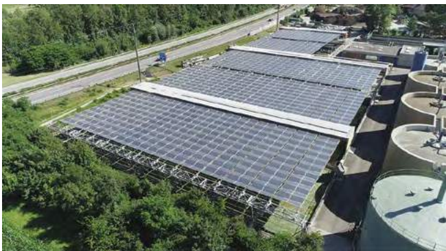
Abb. 2: Das Solarfaltdach wird durch den Faltmechanismus vor Sturm, Hagel und Schnee geschützt und vermeidet damit statische Kräfte. Dies erlaubt sehr weite Stützenabstände und große Höhe über Boden. Hier die ARA Chur bei schönem Wetter.
