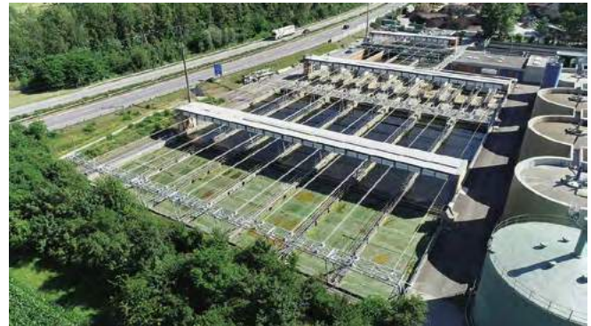
Abb. 3: Bei Hagel, Schnee und Starkwind über 12 m/s oder auch nachts kann das Faltdach auch bei großen Flächen eingefahren werden.
