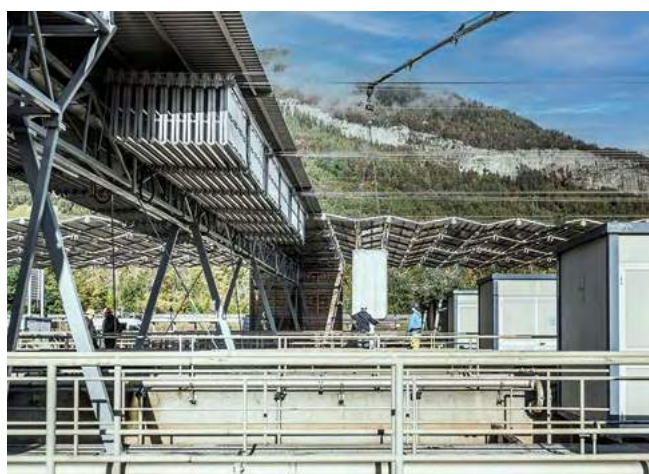
Abb. 1: Dank dem Faltmechanismus bleiben die Zugänge frei für die Wartung und den Zugriff mit dem Kran. Beckenkronen können für die Abstützung des Tragwerks genutzt werden. Zudem wird das Solarfaltdach auf jede beliebige Größe skaliert.
